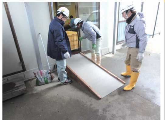
▲スロープの改修
